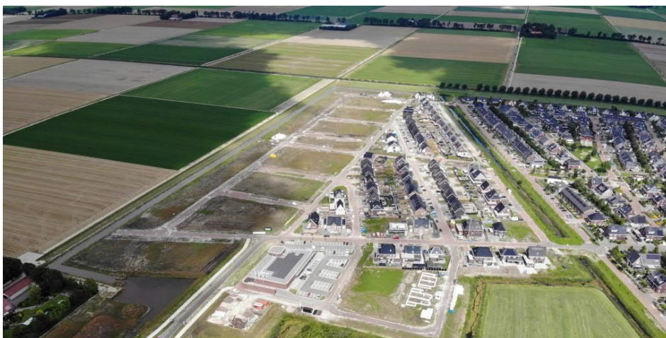
Figuur 15 – Impressie van bouwrijp maken Emmelhage in de Noordoostpolder
