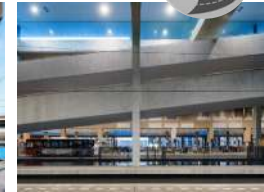
Station Breda, zicht op busstation bij de hellingbaan
